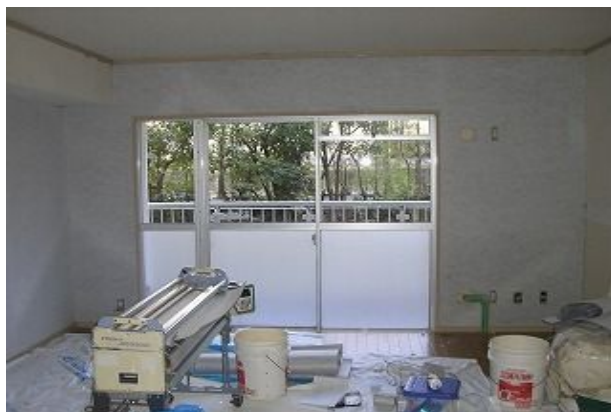
エルシート貼り完了
