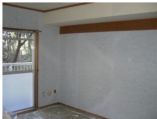
エルシート貼り状況
