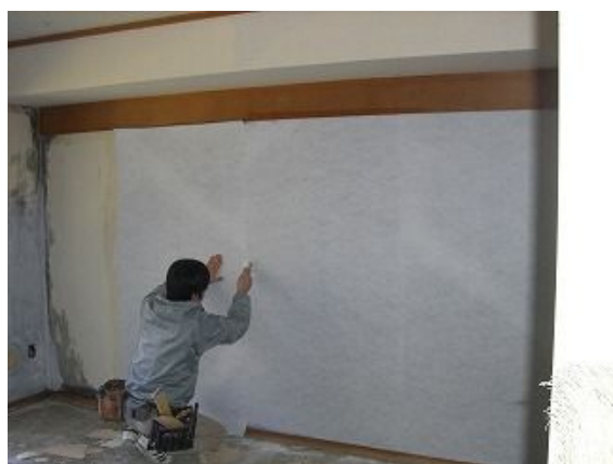
エルシート貼り状況
