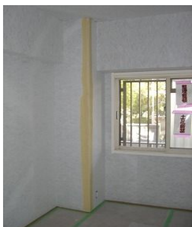
エルシート貼り完了
