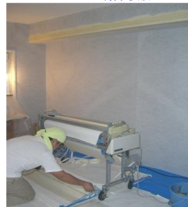
エルシート貼り完了、クロス貼り前
