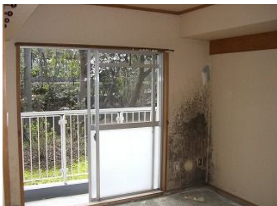
着工前(クロス面カビあり)
